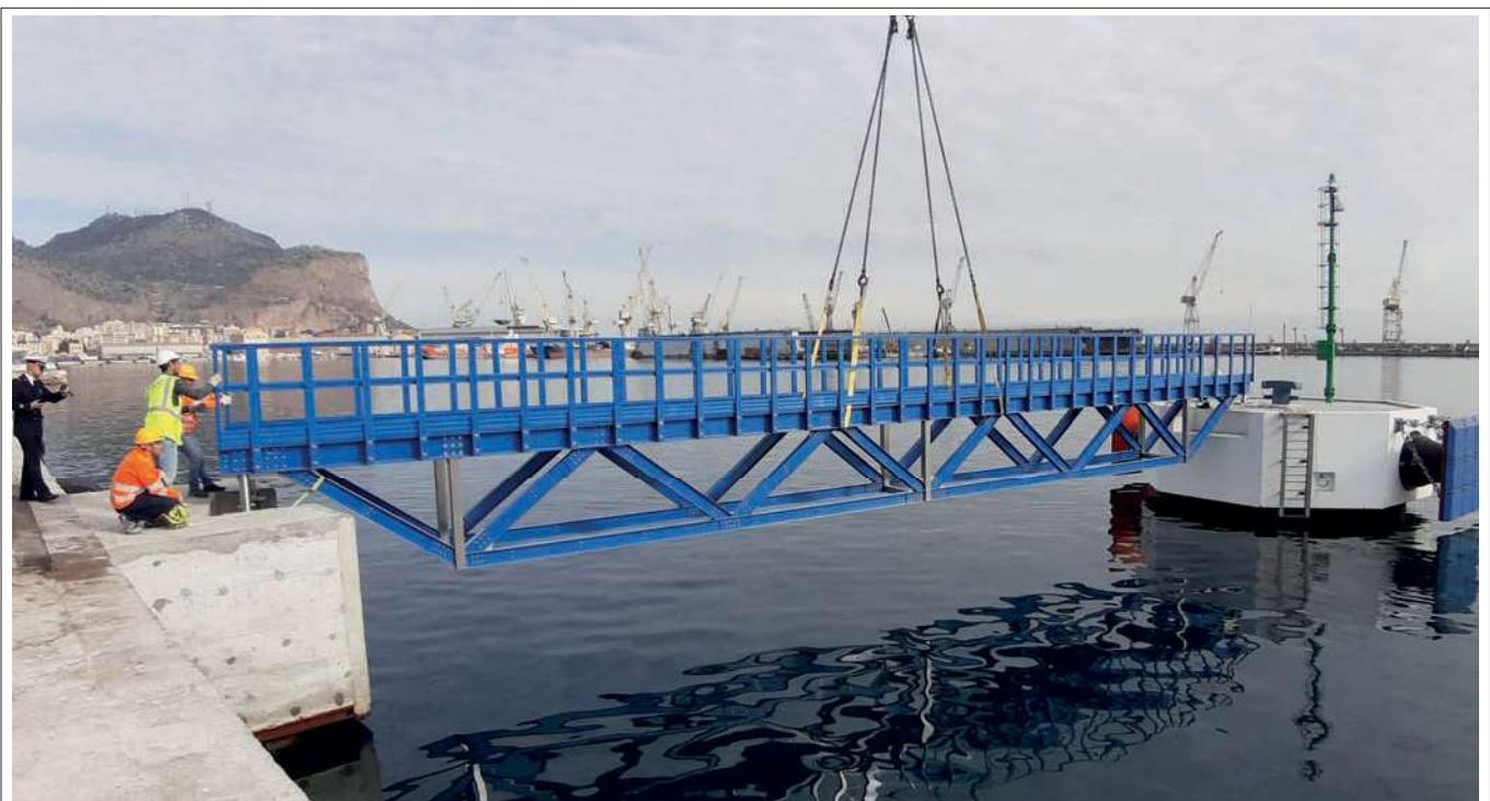
**L'**Autorità Portuale della Sicilia Occidentale è supportata da P-Trex nella realizzazione di una passerella nautica in PRFV, garantendo velocità di posa in opera e abbattendo i costi di manutenzione.
