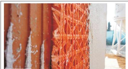
Fig. 3: EQ-GRID. Spessore del sistema applicato
