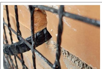
Fig. 2: GFRP. Rete e connettore applicati
