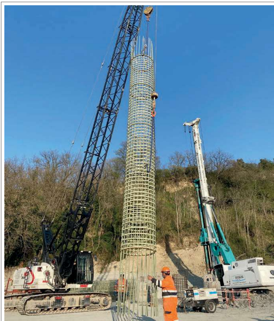
Fig.2: Gabbie in vetroresina per applicazioni Soft Eye
